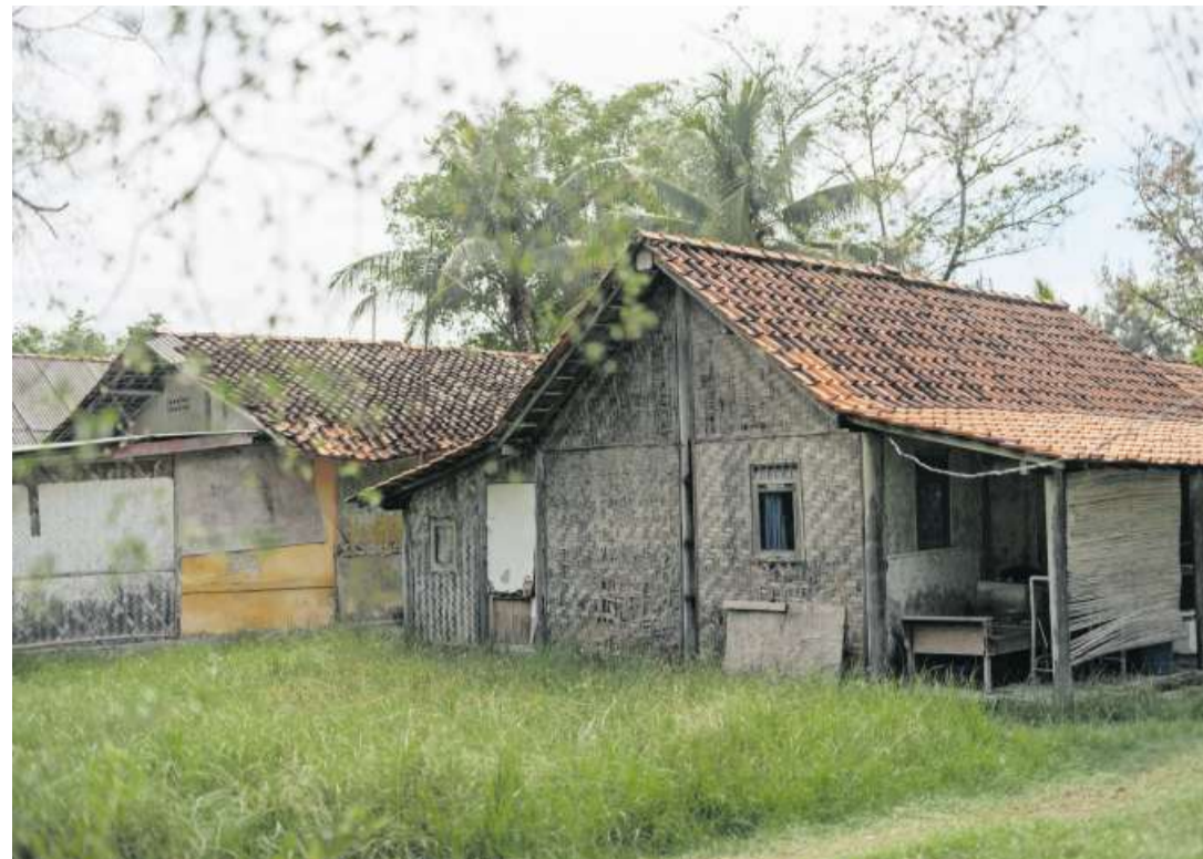
Die Häuser auf Pari sind aus Geldmangel in keiner Weise gegen Hochwasser gesichert.
